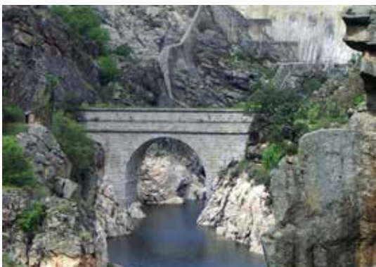
Presa del Villar
