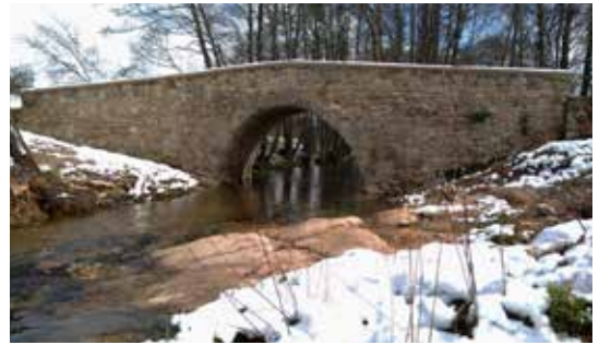
Puente Romano. Lozoyuela
